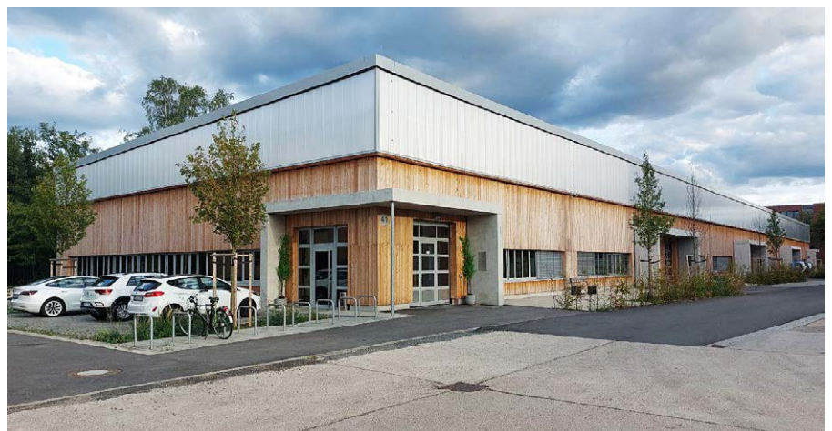
Eine Leichtbauhalle lässt sich auch mit einem ansprechenden Eingangsbereich versehen
