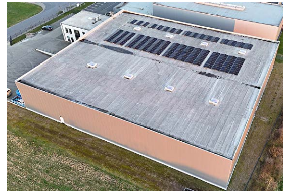
Halle mit Büroanbau aus Porobeton-Elementen
